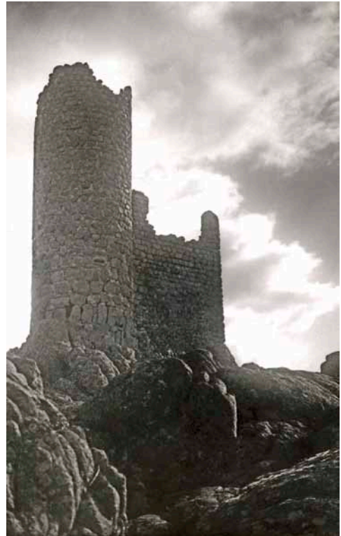
Fig. 3.- Fotografía de la atalaya de Torrelodones a principios del siglo XX de fecha previa a la restauración (archivo J. Pastor, restaurada por G. Kurtz, donada al Archivo Municipal de Torrelodones).
