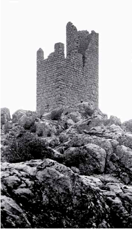
Fig. 2.- Fotografía de la atalaya de Torrelodones a principios del siglo XX de fecha previa a la restauración (archivo J. Pastor, restaurada por G. Kurtz, donada al Archivo Municipal de Torrelodones).
