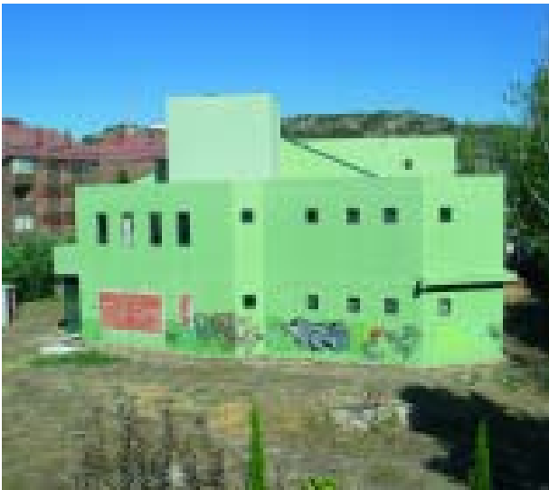
Aspecto actual del edificio ilegal que será derribado en breve
