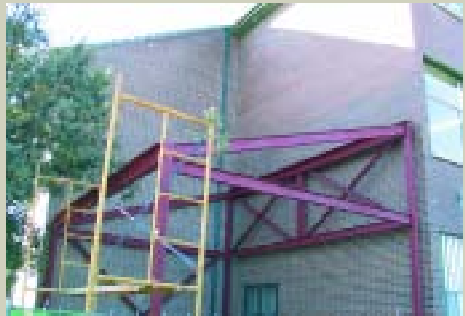
Estructura que acogerá la ampliación del comedor
