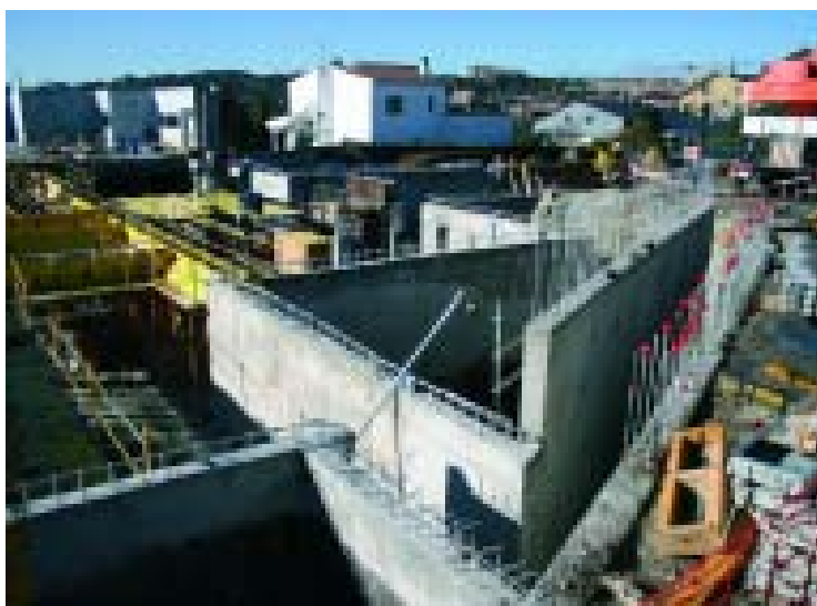
Estado actual de las obras de nueva Escuela Infantil
