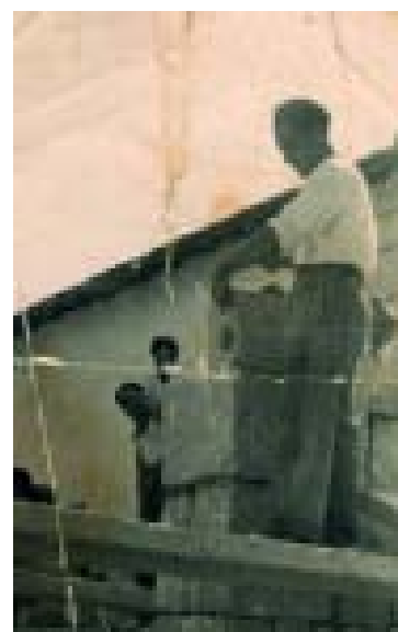
Ángel en la obra de la casa de los maestros
