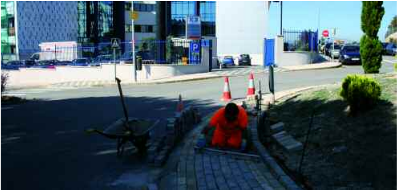
Reposición del adoquinado de la rotonda de acceso a Los Bomberos
