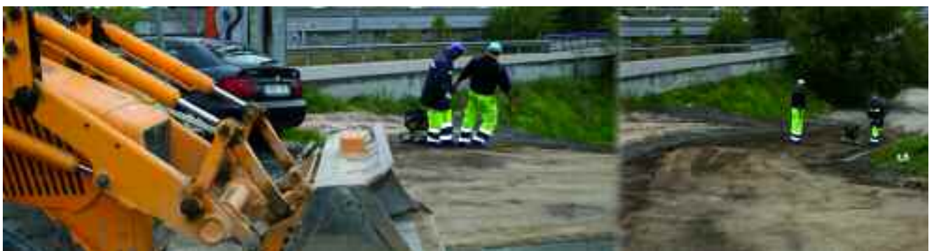
Trabajos de mejora del aparcamiento de la calle Rufino Torres
