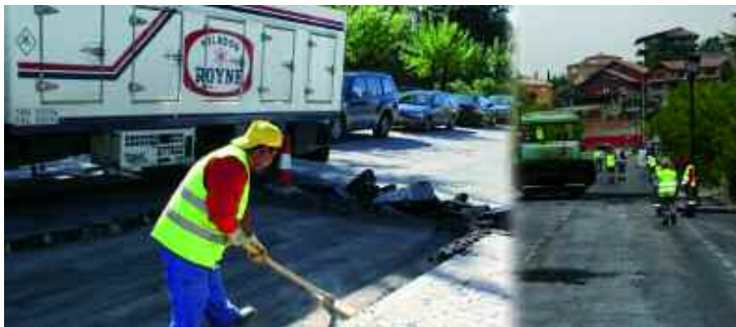
Asfaltado de El Bulevar
